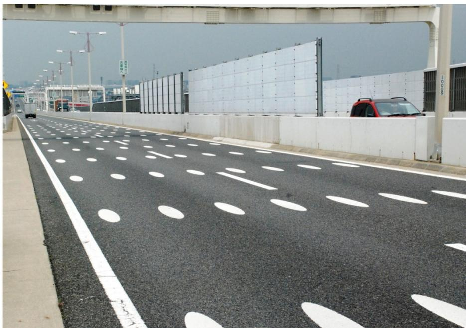
図A 1. オプティカルドットが施工された路面【提供：首都高速道路】
